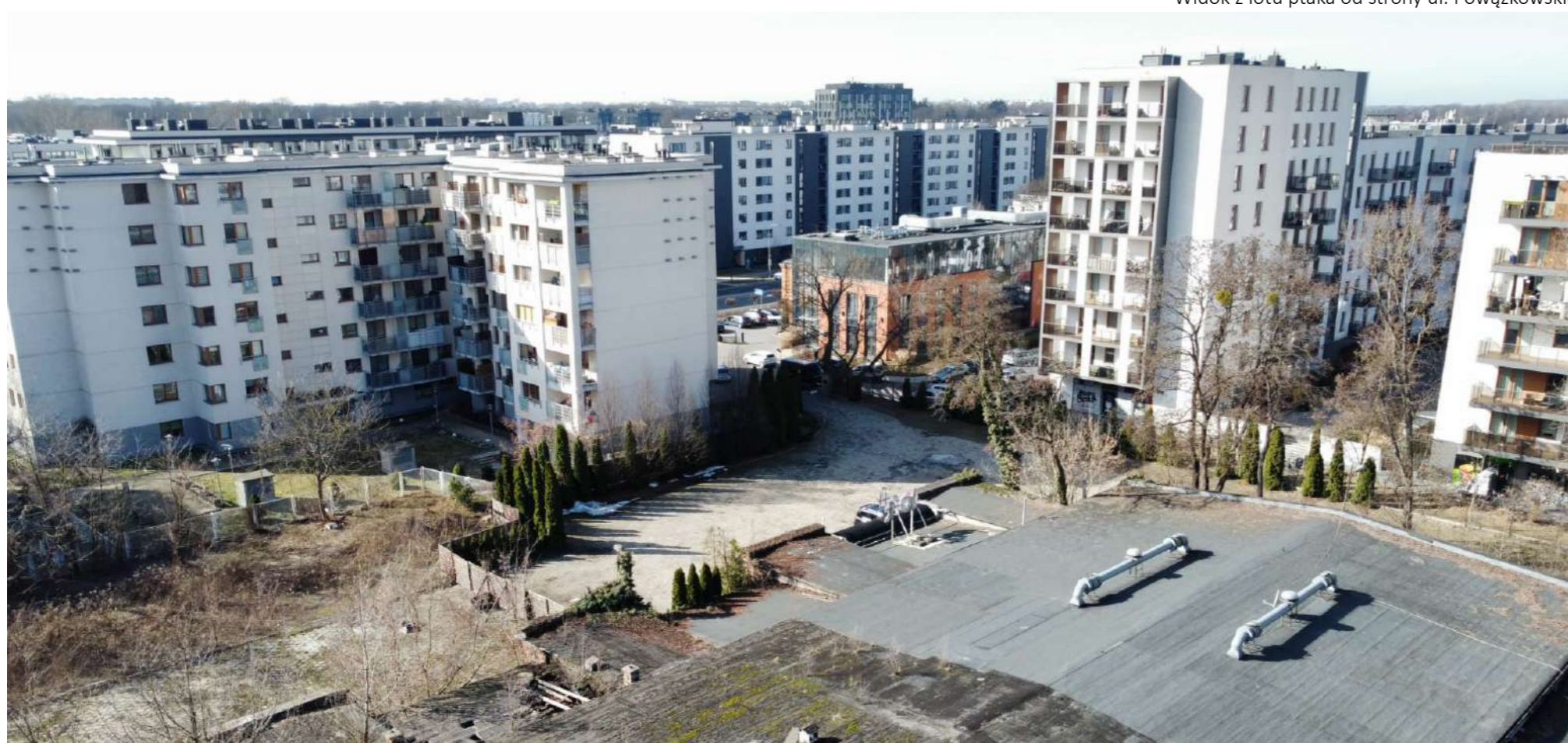
Widok na teren inwestycji od północy w kierunku południowego zachodu
